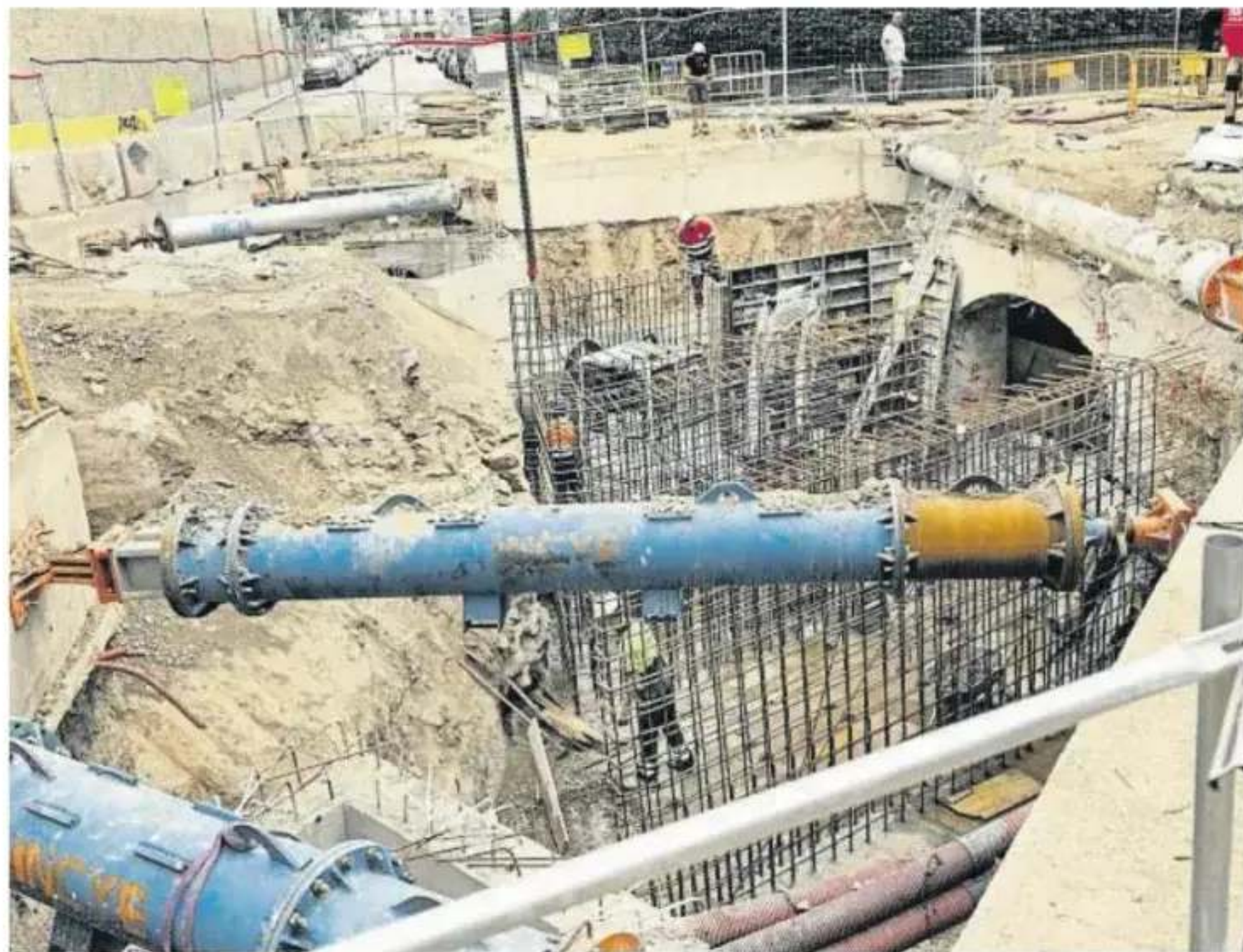
Trabajos previos a la instalación del nuevo colector en la calle Vila i Vilà del Poble Sec
